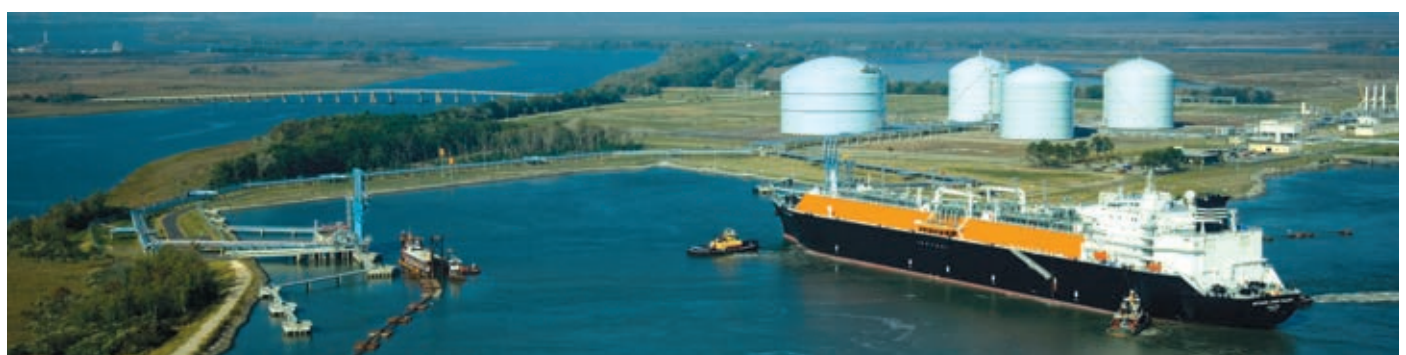
Methane Lydon Volney LNG vessel, Elba Island regasification terminal, USA
